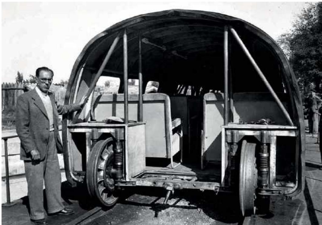
📷 **Detalle del primer prototipo de tren Talgo, construido en Oñati en la fábrica de los Hijos de Juan de Garay.** Archivo EuskoTren/
