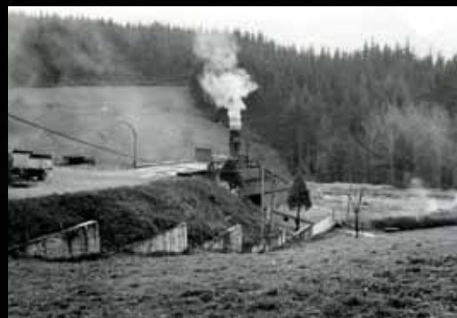
Antigua incineradora de Gaztelua (Abadiño).
