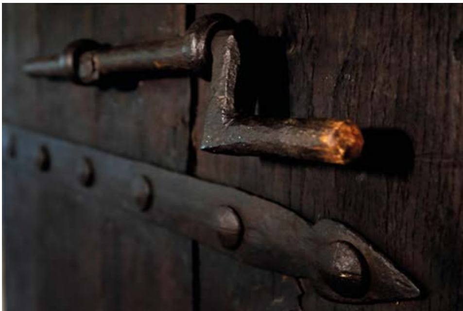
📷 Detalle de la puerta de la celda.
