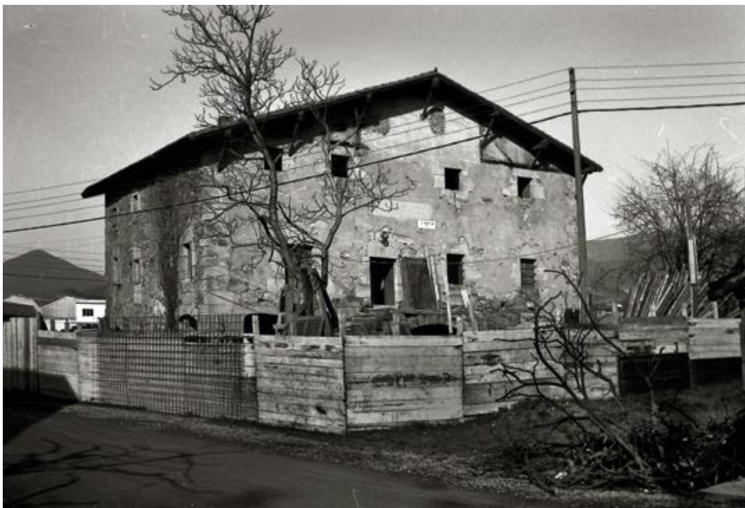
📷 Rehabilitación del auditorio. 1982.
